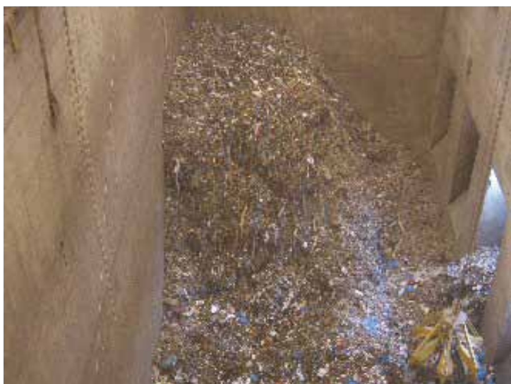
Fossa di scarico
