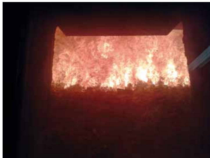
Camera di combustione
