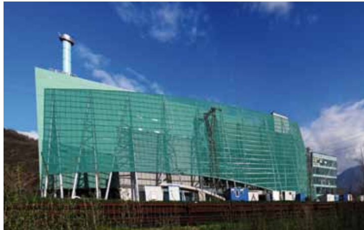
Aussenansicht der Anlage
